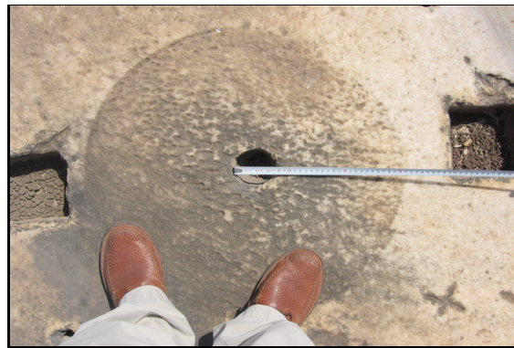
Şekil 1. Sütunu oluşturan dairesel kesitli tambur.
