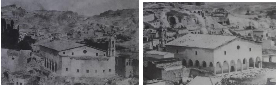
Resim 10: Kilisenin Doğu Cephesi, Çan Kulesi ve Kilisenin Giriş Kısmı, (Balta, 2010).
