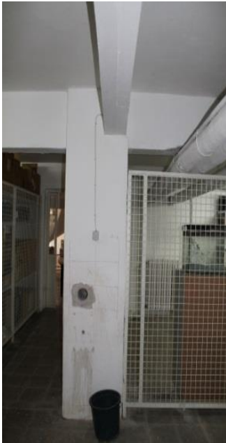
Şekil 3: Beton örneğinin alındığı bir kolon.
