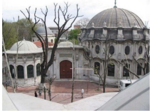
Görsel 11. Türbe ve Sebili Bağlayan Avlu Kapısı Genel Görüntü (FOMGROUP Architects, 2021)
