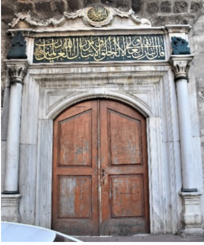
Görsel 7. Kuzeydoğu Avlu Kapısı
