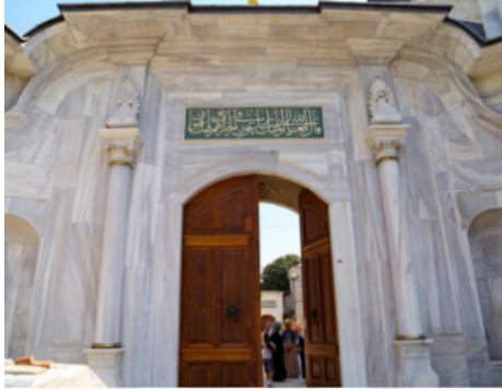
Görsel 10. Kuzey Batı Avlu Girişi Dış Kapı (Koçyiğit, 2019, 26.)
