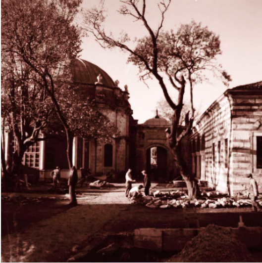
Görsel 3. Fatih Külliyesi Nakşidil Sultan Türbesi, Ali Saim Ülgen Arşivi
