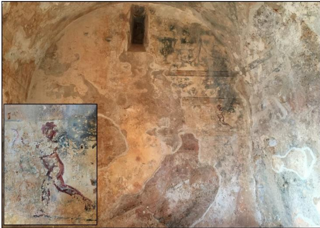
Şekil 28. A IV 7A Mezarı duvar freskinin konservasyon ve restorasyon uygulamaları sonrası görünümü
