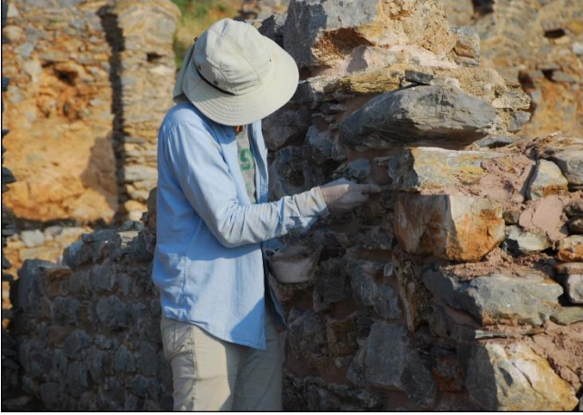
Şekil 18. Mimari kalıntılar üzerinde yapılan konservasyon ve restorasyon çalışmaları-Nekropol Kilisesi
