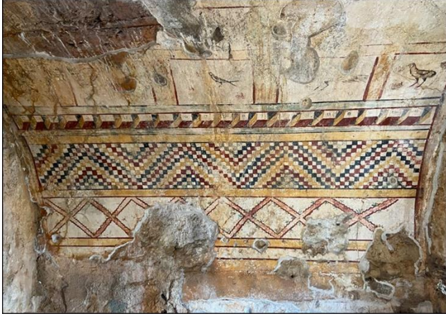
Şekil 27. A VI 2 Mezar duvar freskinin konservasyon ve restorasyon uygulamaları sonrası görünümü
