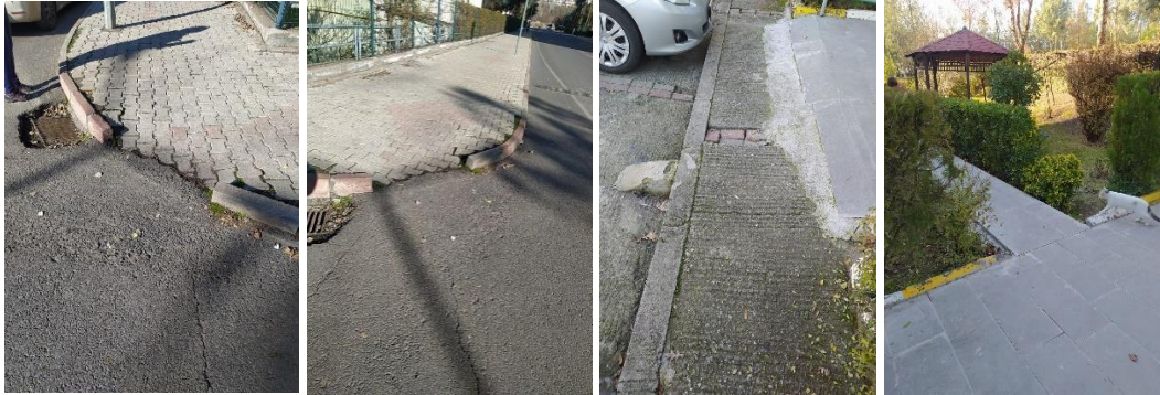
Şekil 12. Şilbe konut yerleşkesinde yürüme yolları ve kaldırımlar
