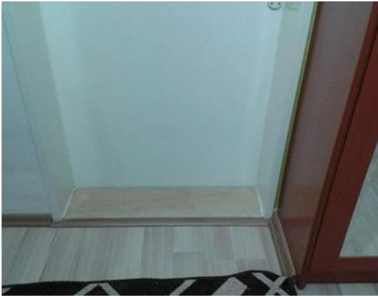
Şekil 65. Oda kapısı eşik örneği
