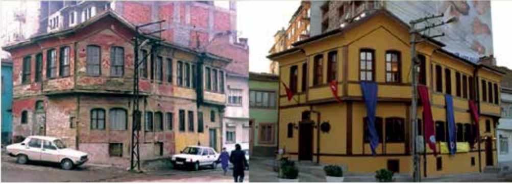
Resim 1 Eğitim Karikatürleri Müze Binasının Restorasyon Öncesi ve Sonrası Görünümü
