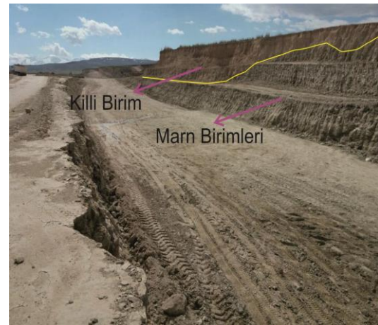
Şekil 15. Km: 218+500 bölgesi killi birim ile marn arasındaki dokanak sınırı
