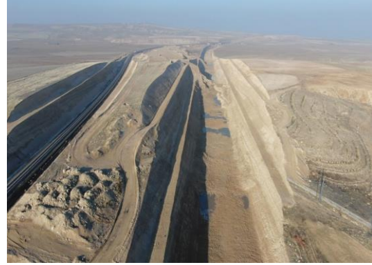
Şekil 21. Km:220+000 kazı şevlerinin görünümü
