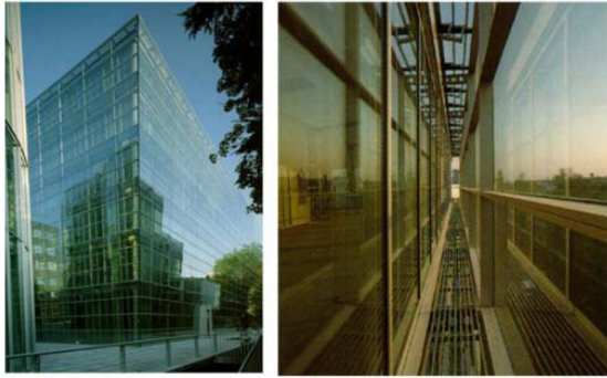
Şekil 5. İç ve dış cidarda güneş kontrol camları (solar control glasses indoor and outdoor skin)
