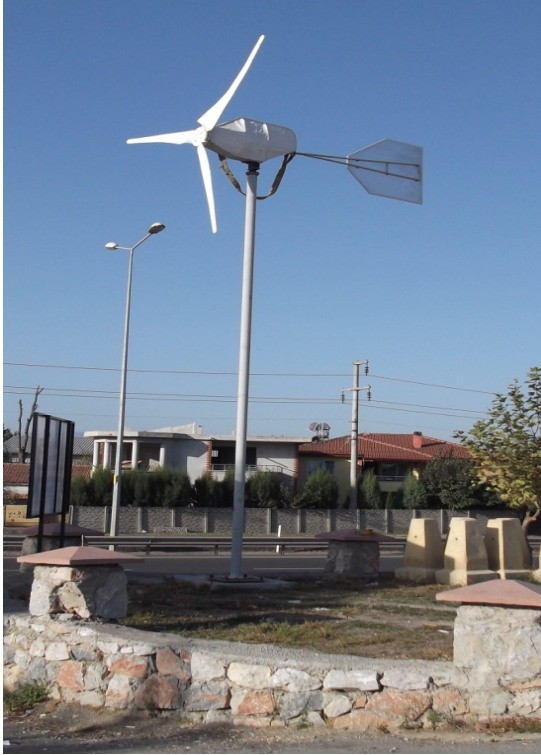
Şekil 14. Montaj işlemi tamamlanan türbin (Turbine completed assembly process)
