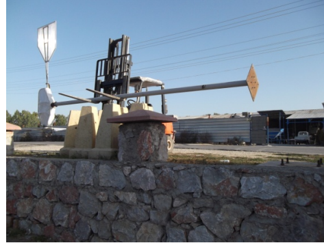
Şekil 13. Sistemin ankraj zeminine montaj edilmesi (Anchor to the floor of the assembly system)
