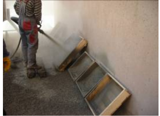
Şekil 1. Deney panellerine kuru karışım püskürtme betonun Uygulanması (Çakiroğlu, 2007)
