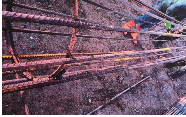
Şekil 21. Fore Kazık Donatı Hazırlama
