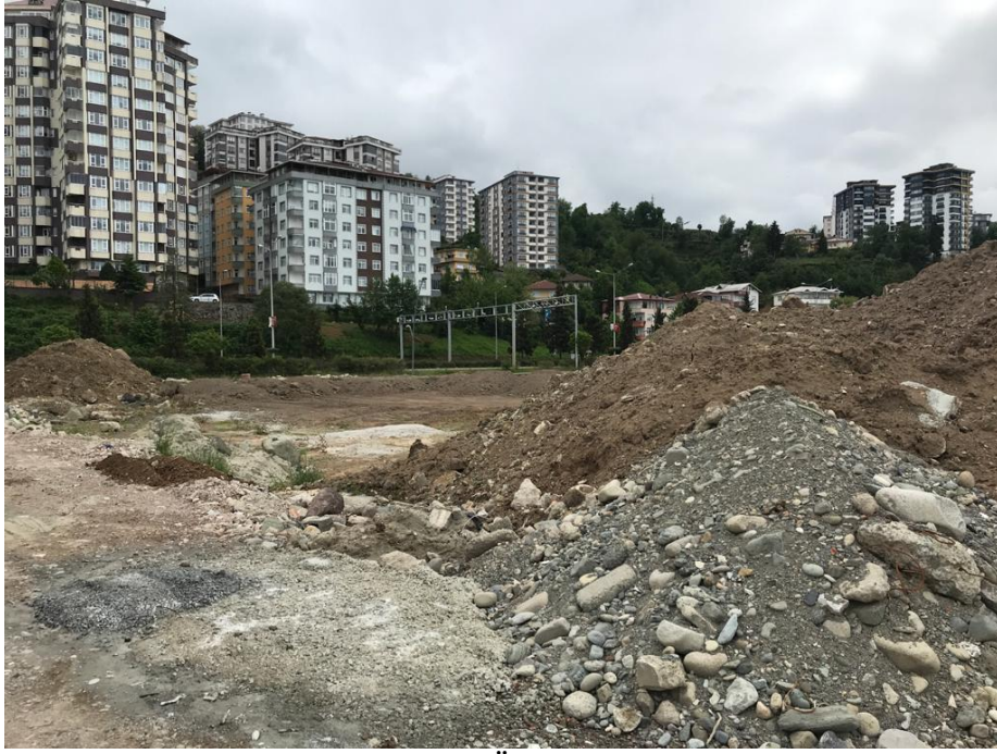
Şekil 15. Rize Batı Park Ön Yükleme Yapılan Alan
