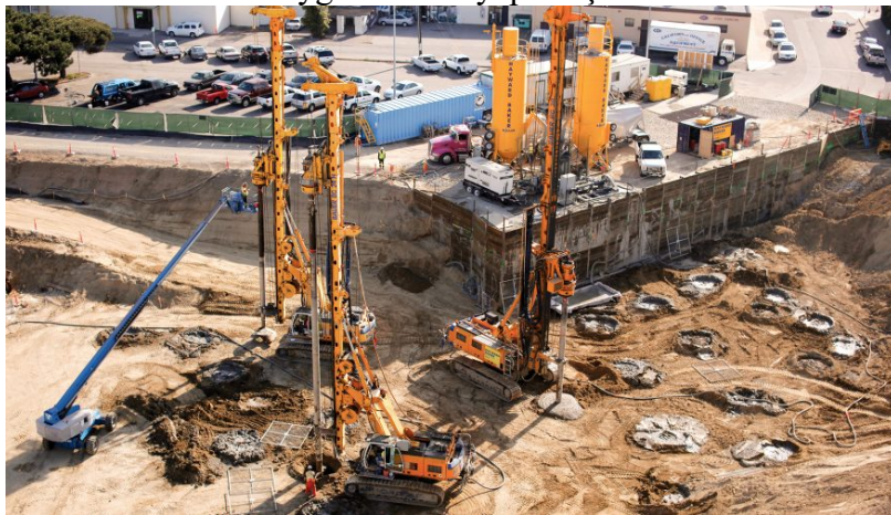
Şekil 1. Zemin İyileştirmek İçin Yapılan Bir Çalışma
