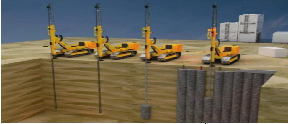
Şekil 3. Fore Kazık Donatısı ve Uygulaması (Özdemir, 2021)
