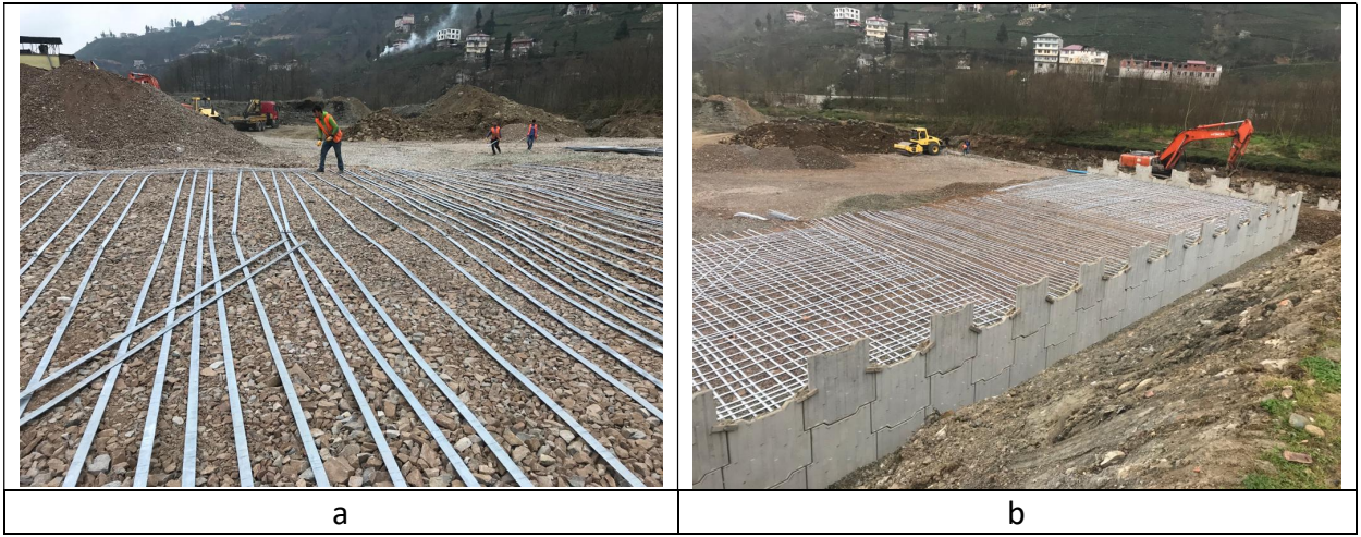
Şekil 6. Polimer Şerit Donatısı Ve Uygulaması (Salarha-2021)
