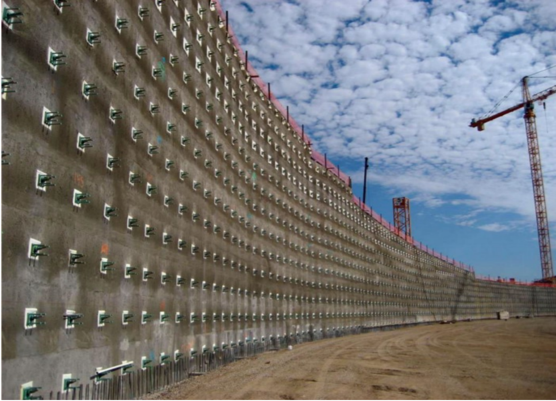
Şekil 9. Zemin Çivisi Donatısı ve Uygulaması (Şahin,2019)
