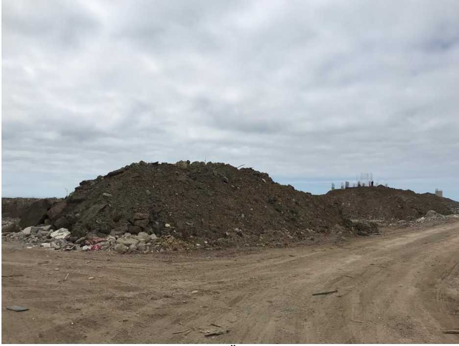
Şekil 16. Rize Batı Park Ön Yükleme Yapılan Alan
