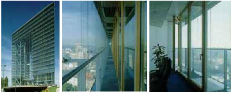
Şekil 4: Düsseldorf City Gate Binası Çift Cidarlı Cephe Sistemi (Poirazis, 2006).
