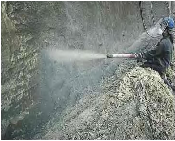
Şekil 6. Çelik lifli betonun, püskürtme beton uygulaması (Bekaert, 2011)
