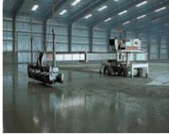
Şekil 4. Çelik lifli betonların, fabrika depo ve hangar döşemesi uygulaması (Bekaert, 2011)
