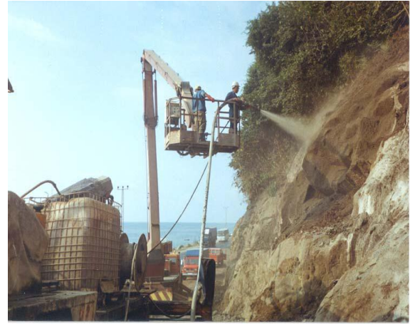
Şekil 7. Çelik lifli betonun, şev stabilitesinin sağlanması (Bekaert, 2011)
