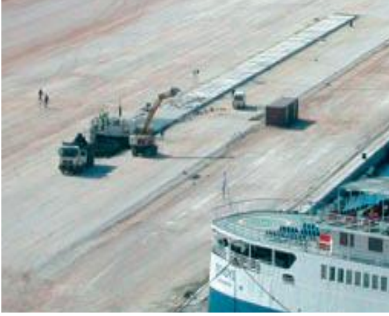
Şekil 5. Çelik lifli betonların liman kaplamalarında uygulanması (Bekaert, 2011)
