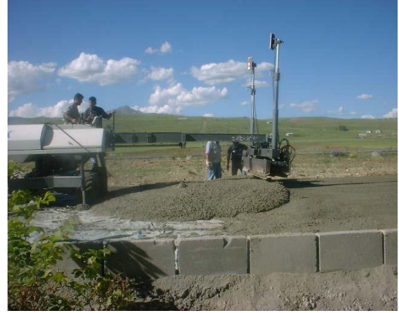
Şekil 2. Çelik lifli betonun yol döşemelerinde uygulaması (Bekaert, 2011)
