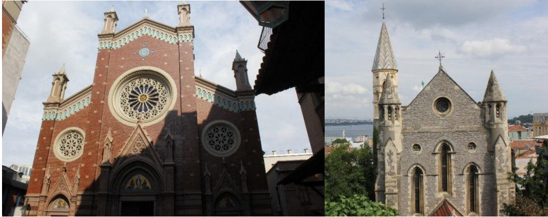
Res. 2: XIX. yüzyılda Osmanlı başkentinde Neogotik tarzda inşa edilen bina örnekleri (solda St. Antuan Kilisesi (1912), sağda Kırım Anı Kilisesi (1868)).
