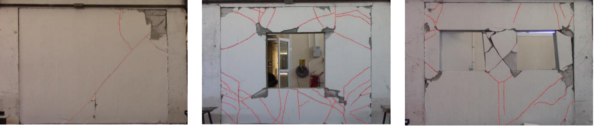
Şekil 11. %3,5 ötelenme oranında, dolgu duvarlarda meydana gelen hasarlar.
