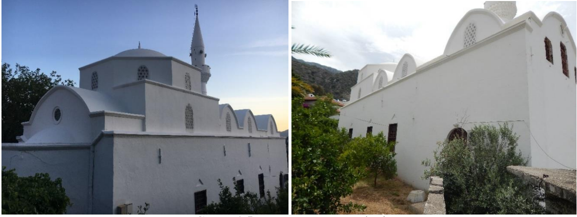
Görsel 4-5: Yapının Kuzey Cephesi
