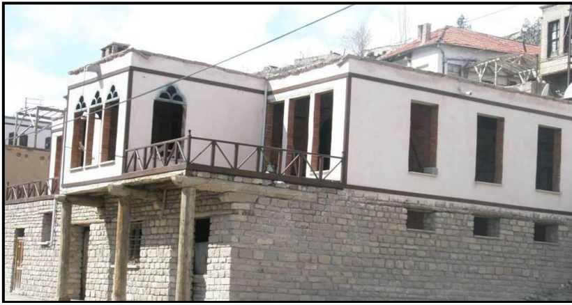
Foto 5. Sille taşı ile inşa edilen modern görünümlü Sille konutu. Photo 5. Modern-looking Sille residence built with Sille stone.
