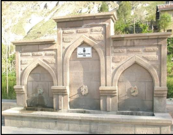
Fotoğraf 14. Sille'de restore edilmiş çeşme. Photo 14. Restored tap in Sille.
