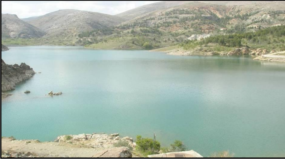
Fotoğraf 2. Sille Barajı'nın güneyden görünüşü Photo 2. South view of Sille Dam
