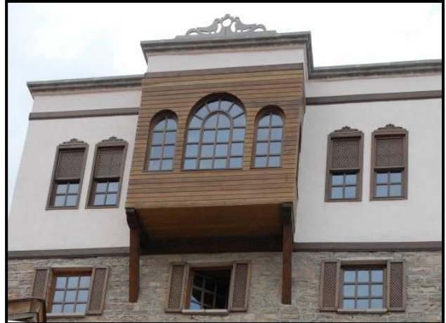
Fotoğraf 8. Sille’de restore edilmiş konut. Photo 8. Restored residence in Sille.
