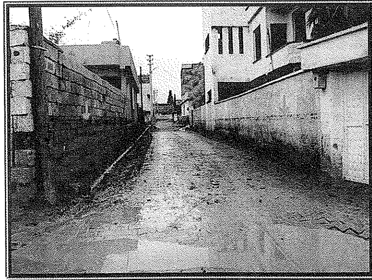
Foto 3: Ceylanpınar ilçe merkezinde tıkalı menfez ve dere yatakları nedeniyle su baskınlarına maruz kalan mahallelere bir örnek: M. Akif Ersoy mahallesi'nde sel suları, okla işaretli seviyeye kadar yükselmiştir (Kasım 2006).
