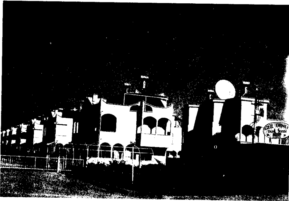
Foto 6- Sahil caddesindeki ikinci evler. Figure 6- Secondary houses in Sahil street.
