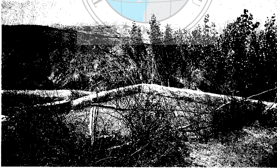
Foto 2. Yaz aylarında tarım arazilerini sulamak için yapılan havuzlar zemindeki oturmalardan nedeniyle tahrip olmakta ve her yıl bakım-onarım yapılmaktadır.
