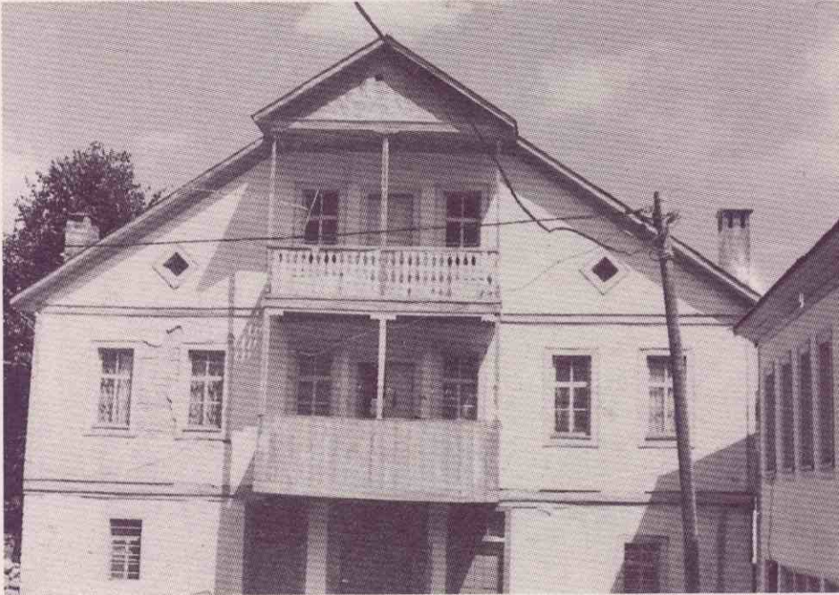
Fotoğraf 2- "Bağdadi" tarzda inşa edilmiş bir mesken Photo 2- A house built in the "Bağdadi" style
