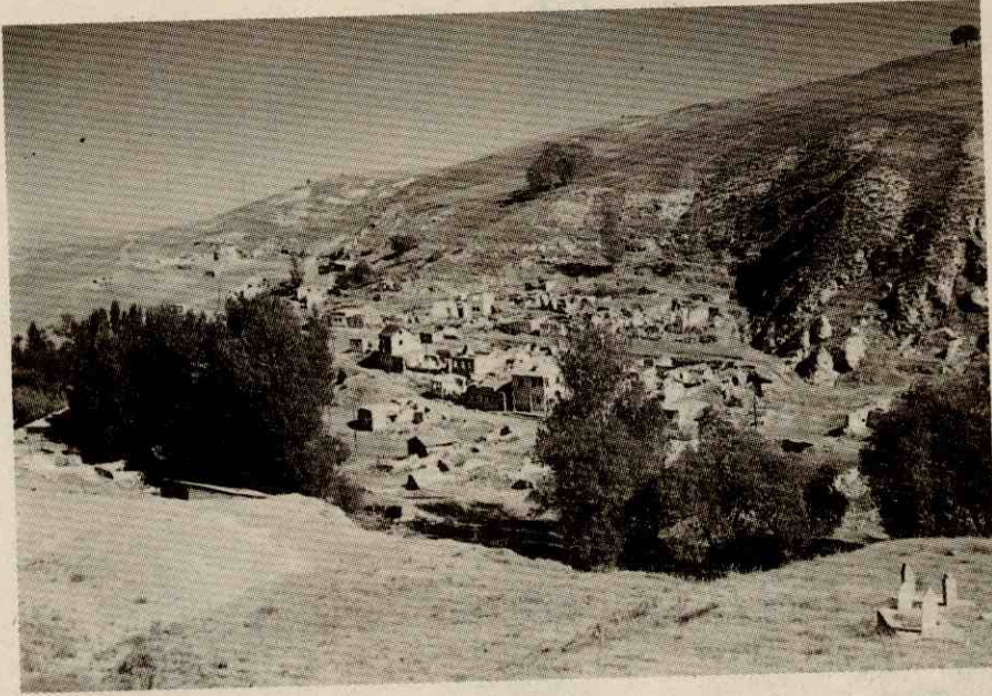
Fotoğraf 3- Heyelan nedeniyle yeri değiştirilen Şihveren (Gümüşseren) köyü. Photo 3- Şihveren vililge the location of which was changed due to landslide.
