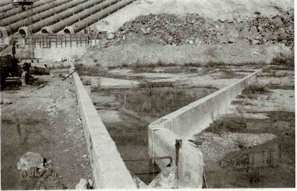
Fotograf 5: Dik açılı üçgen savaktan bir görünüm. Photo 5: Perpendicular weir.
