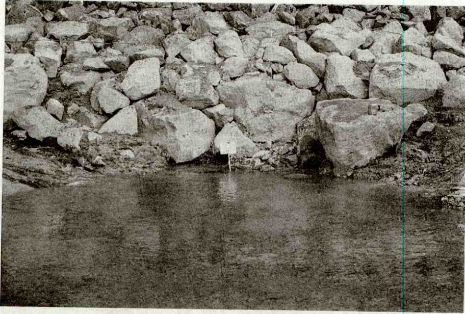
Fotograf 3: Baraj topuğundaki kaynaklardan bir görünüm. Photo 3: Resources located on the toe of dam.
