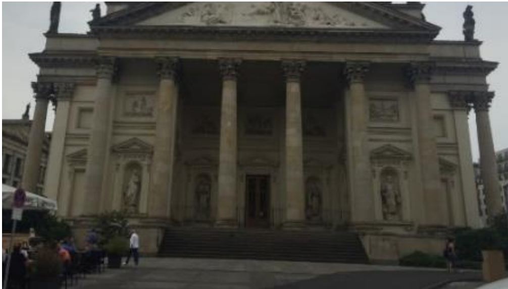
Image 15: Niches and panels on the east facade of the Französischer Dom.
