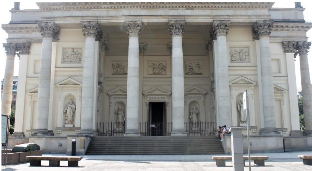
Image 11: Niche and panels on the east facade of the Deutscher Dom.
