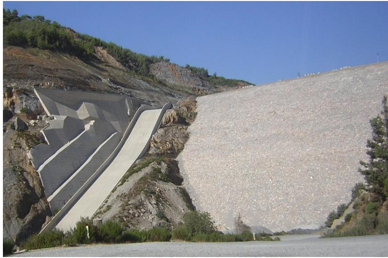
Şekil 2. Mansap Tarafından Baraj Gövdesi ve Dolu savağın Görünüşü
