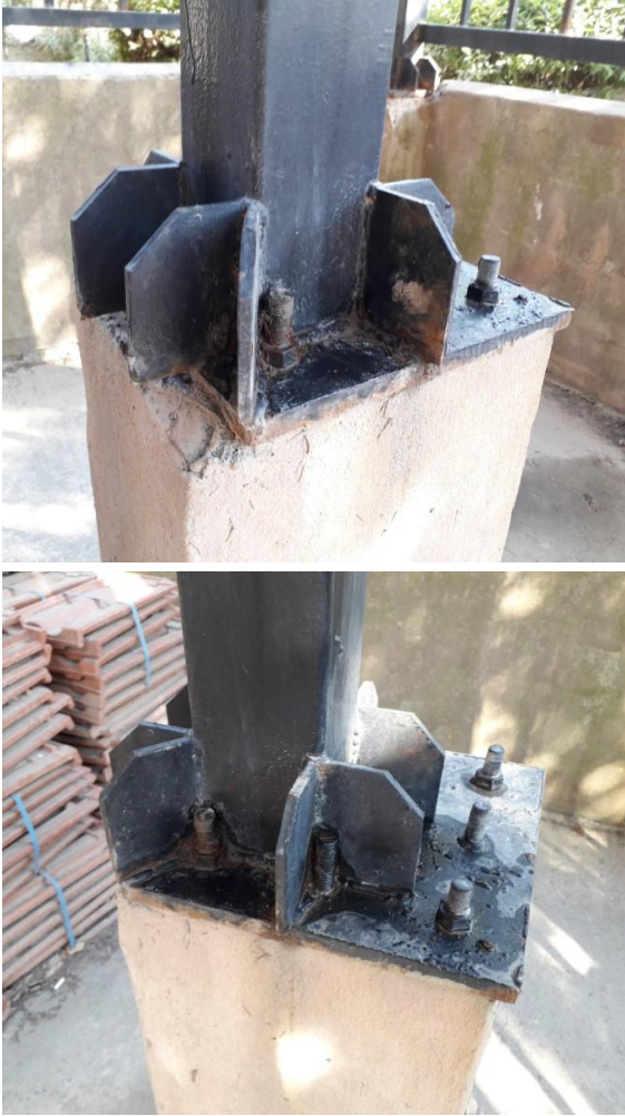
Şekil 1. Kusurlu bir ankastre kolon birleşiminin farklı açılardan görünümü
