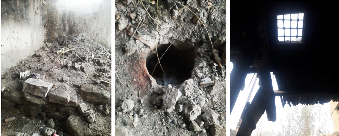
Resim 16. Tandır evinde bulunan tandır ve üzerindeki açıklığın görünüşü
