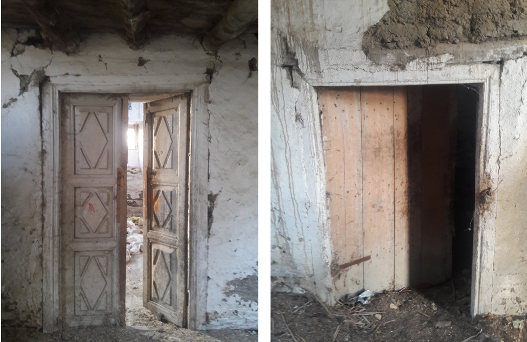
Resim 13. Derviş Demircioğlu evi- çift kanatlı ve tek kanatlı, ahşap oda kapısı örnekleri
