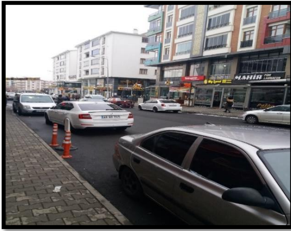
Resim 7. ŞMG Mah. Yeni Apartmanlar ve Dükkânlar
