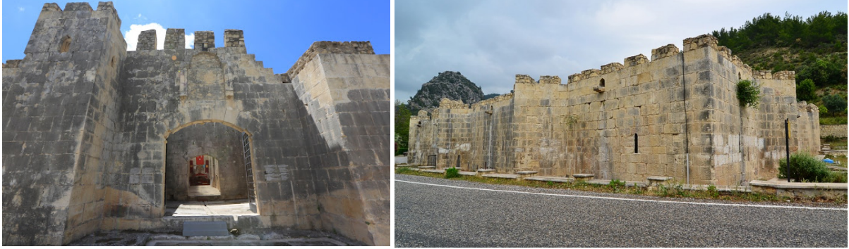
Şekil 24. Alara Hanı giriş portalı ve dış cephe (URL 8)
