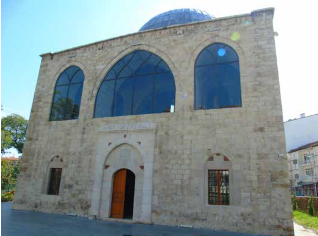
Şekil 5: Taşhoran Kilisesi, Batı Cephesi, Restorasyon Sonrası 2020
