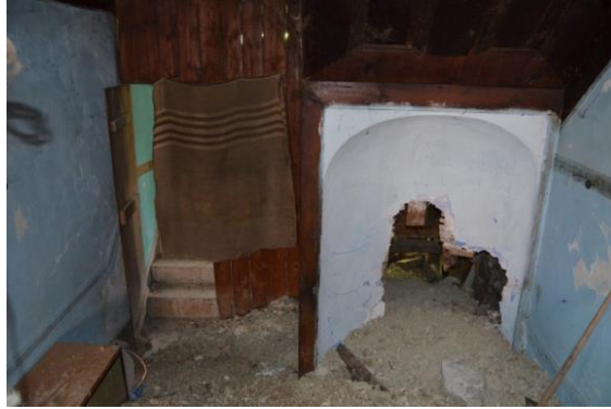
Görsel 16: Zemin Kat İç Sofa Merdiven Altı.
