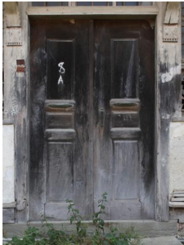
Görsel 35: Zemin Kat Giriş Kapısı.
