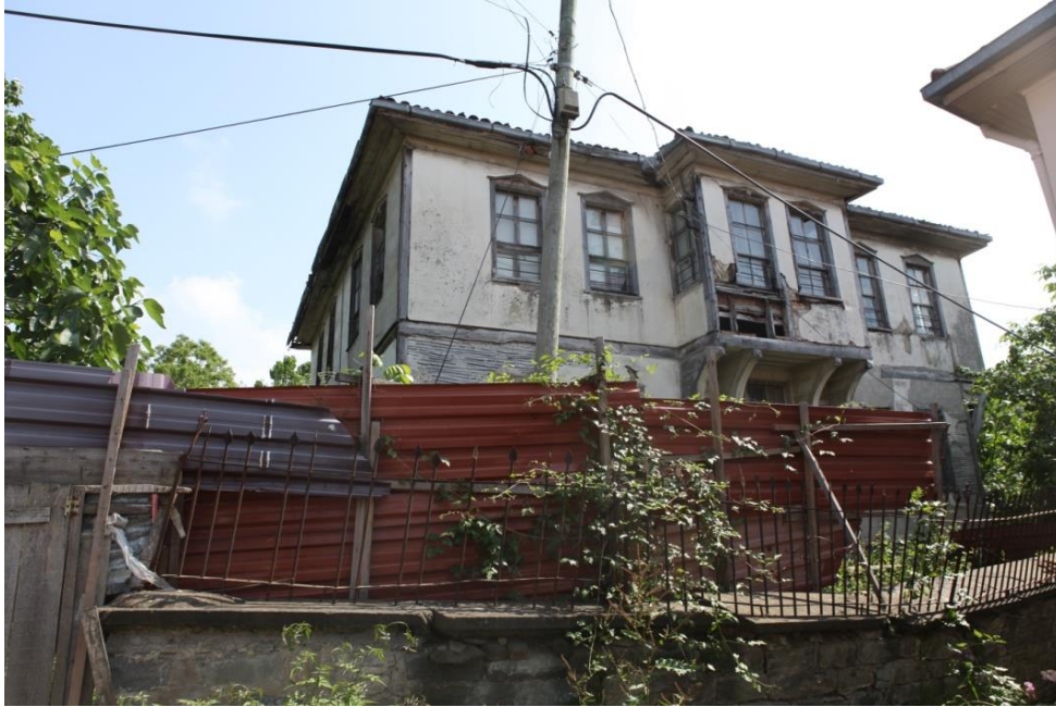
Görsel 7: Kuzey Cephe.
