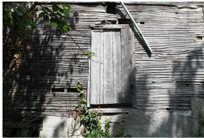
Görsel 44: Bağdadi Duvar Detayı.
