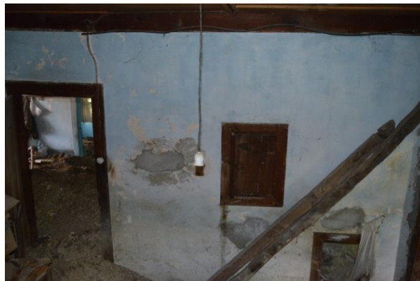
Görsel 21: Zemin Kat Sofanın Güneybatısında Yer Alan Mekân.
