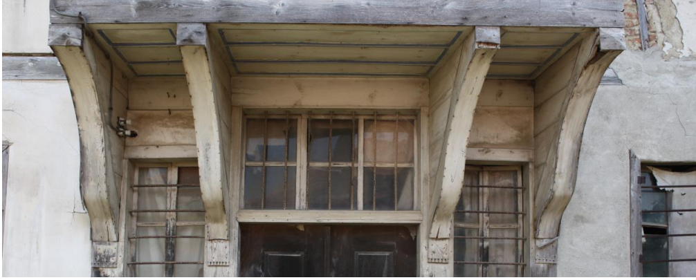
Görsel 40: Çıkmanın Altı Ahşap Pasalı Tavan Uygulaması.
