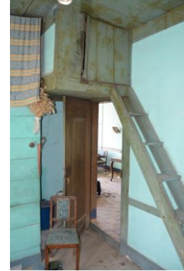
Görsel 31: Birinci Kat Sofanın Güneybatısında Yer Alan Mekândan Çatı Çıkışı.
