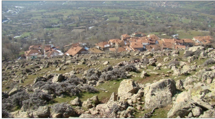
Foto 5: Bağbaşı Köyü konutları ve düşme riski yüksek kaya blokları.
