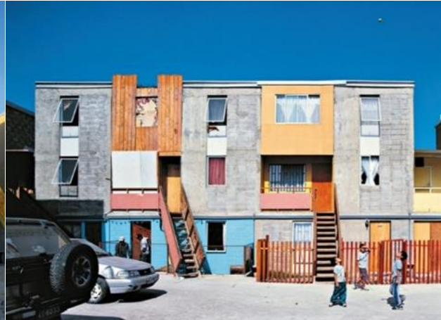
Şekil 32. Yapı sakinleri yerleştirildikten sonra tamamlanan kısımlar
