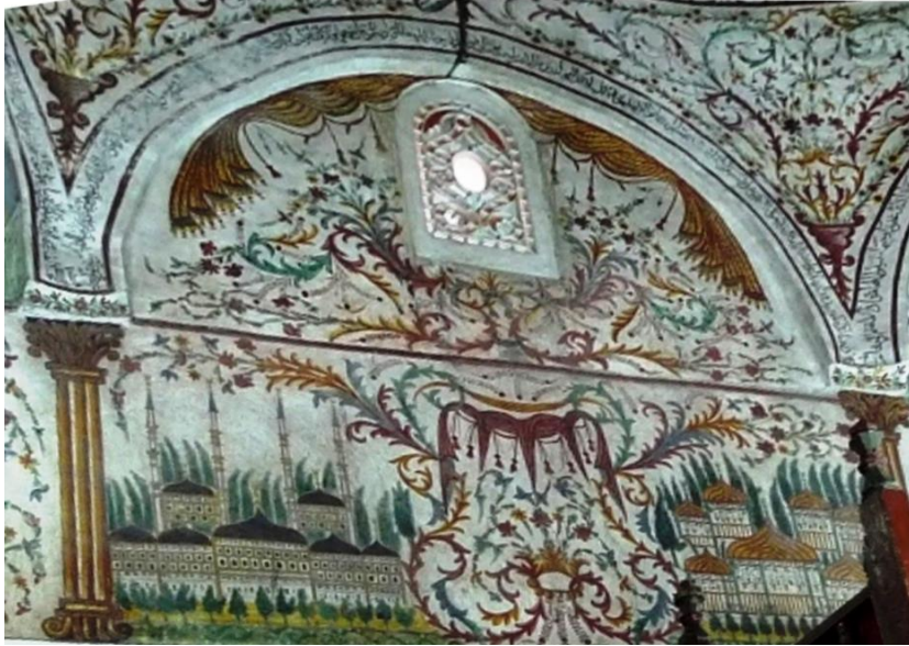
Resim 11. Hacı Ethem Bey Camii kuzey duvarı
