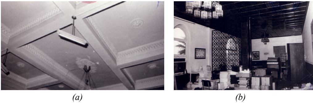
Şekil 5: Vali Konağı döşeme değişimine ait fotoğraflar (a) Günümüz tavan döşeme örneği (b) Özgün tavan döşeme örneği
