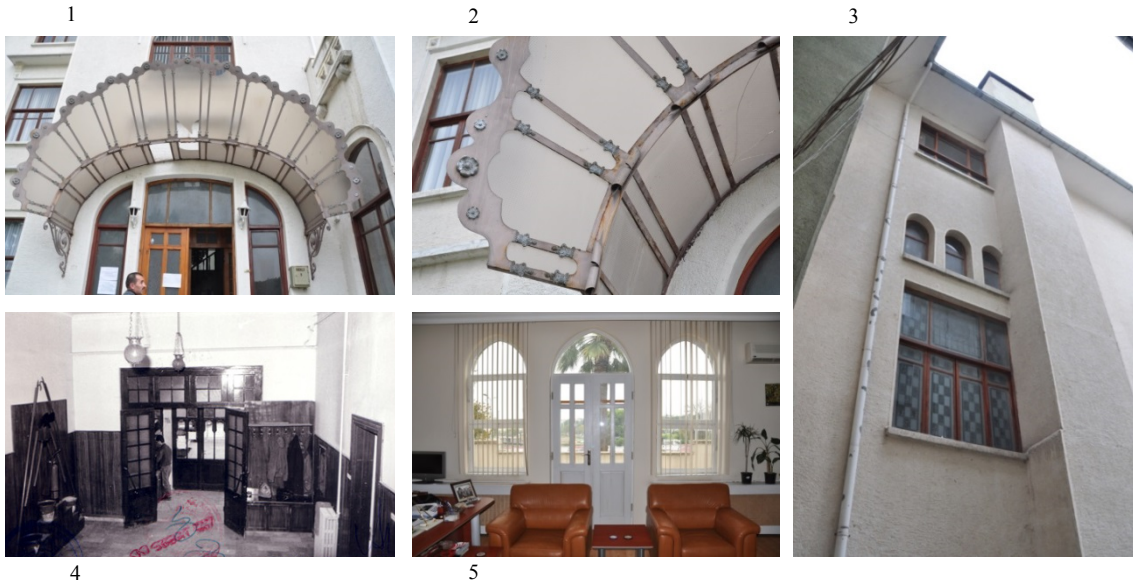
1-)Vasıf Çınar Caddesi cephesinde giriş saçağı, 2-)Vasıf Çınar Caddesi cephesinde giriş saçağından ayrıntı 3-)Merdiven Kovanının arka cepheden görünümü, 4-) Giriş Holünün iç mekândan görünüşü, 5-) Üst katta balkona çıkan kapı ve pencere görünüşleri
