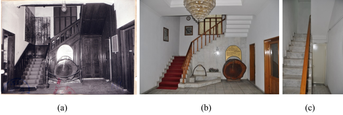
Şekil 4: Vali Konağı düşey sirkülasyon elemanları (a) Giriş holünde yer alan ana merdivenin özgün durumu (b) merdivenin günümüz durumu (c) çatı katına ulaşımı sağlayan merdiven
