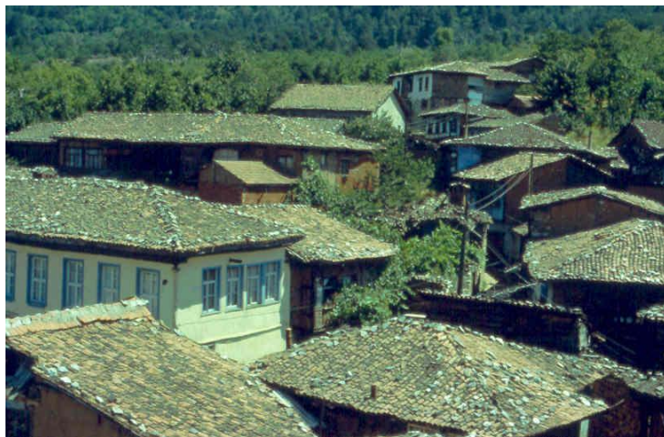
Şekil 8: Cumalıkızık Evlerinde Çatılar Kaynak: N. Akıncıtürk Arşivi
