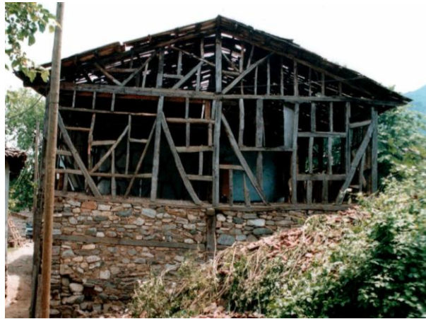
Şekil 3: Cumalıkızık Evlerinde Ahşap İskelet Sistem Kaynak: Z.S. Perker Arşivi, 1999
