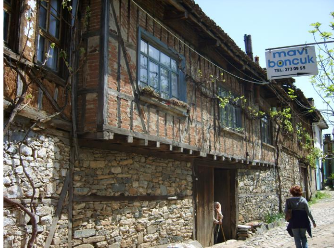
Şekil 7: Cumalıkızık Geleneksel Konutlarında Dikdörtgen Çıkma Oluşumu Kaynak: Z.S. Perker Arşivi
