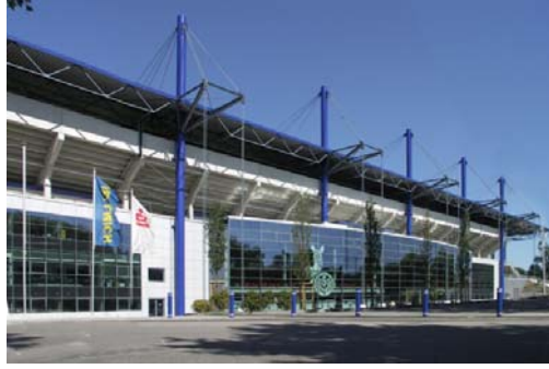
Şekil 3: MSV Arena Futbol Stadyumu Ön Cephe ( http://www.duisburg.de/worldgames_archiv/_upload/sportstaetten/bild_1/image1_16.jpg )
