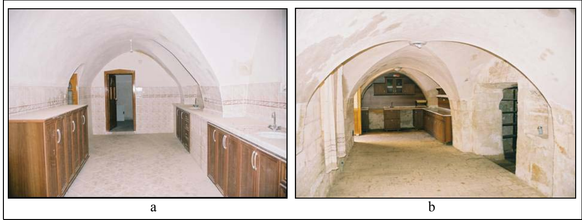
Şekil 12: İç donanımı değiştirilerek mutfaka dönüştürülmüş kilerler
