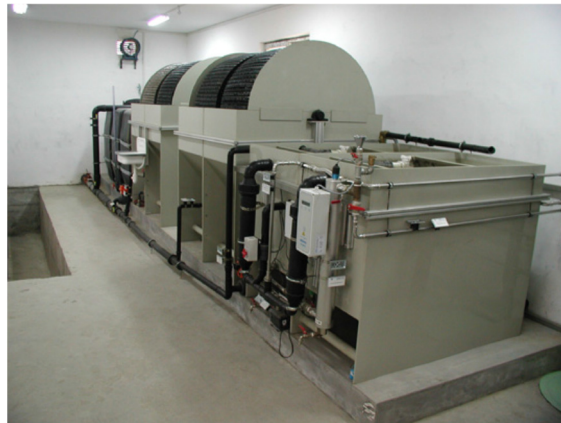
Şekil 5: Döner Biyolojik Disk
