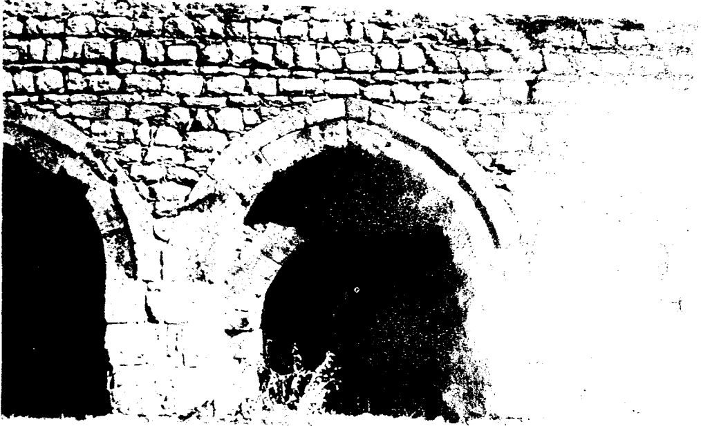
Resim : 14 — 4. No. lu mekanın avludaki görünüşü
