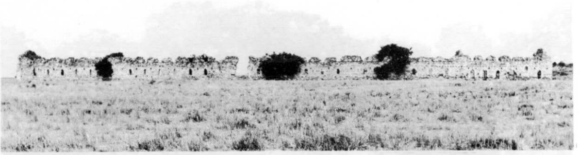
RESİM: 1 Kervansarayın güneyden görünüşü.
