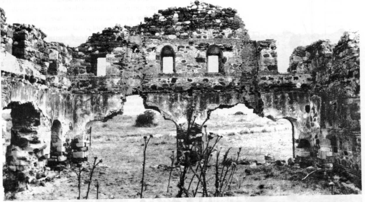
RESİM: 4 Ocakların yer aldığı doğu duvarı.
