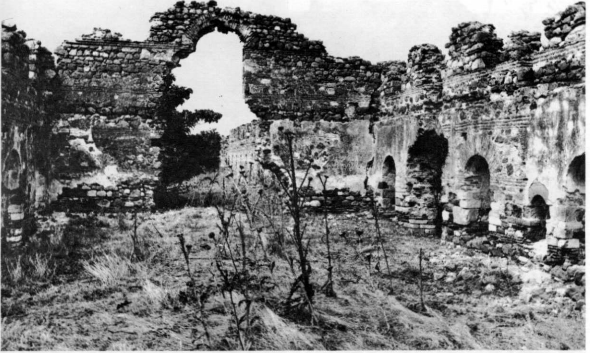
RESİM: 6 Doğudaki mekânın ayırıcı duvarı ve üzerindeki ikinci kata ait kemerli kapı açıklığı
