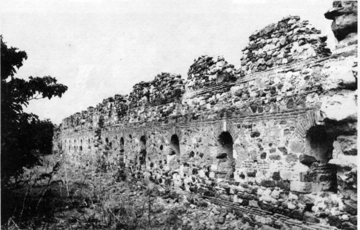
RESİM: 7 Kuzey beden duvarının içerden görünüşü, bu duvar üzerinde ayırıcı duvarların izleri ve ahşap katın döşeme kirişlerinin oturduğu duvar çıkıntısı.
