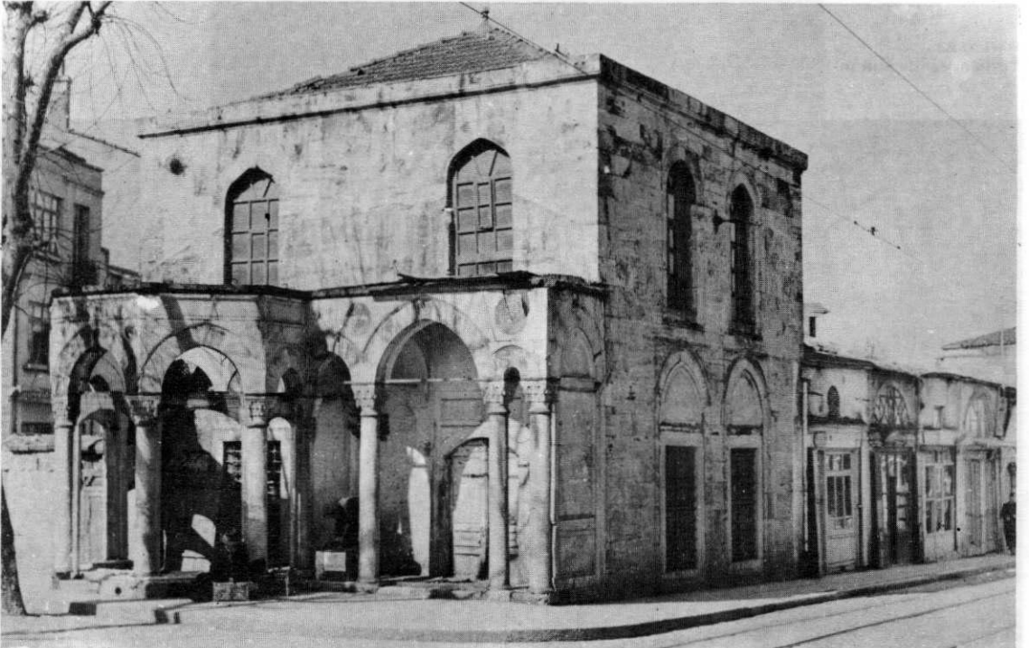
Resim: 21 Kuyucu Murad Paşa Türbesi (Sebili), restorasyon öncesi.
