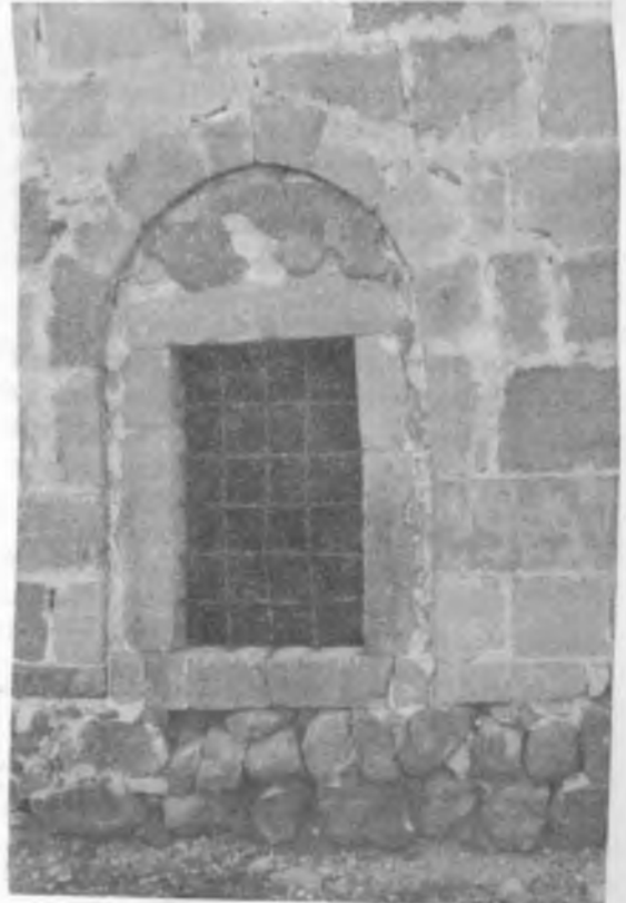
RESİM:5 Mescidin doğu cephesindeki pencere
