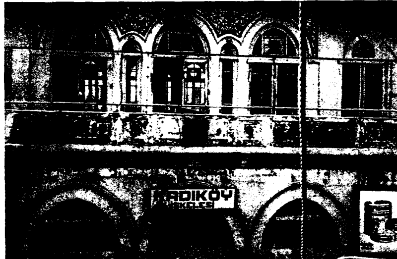
FOTO: 12 Kadıköy İskele binası deniz cephesinin görünüşünden detay
