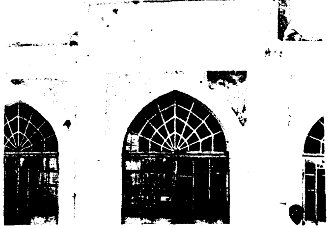
FOTO: 11 Moda İskele binası deniz cephesinden detay
