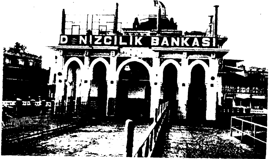
FOTO: 5 Büyükkada iskele binasının deniz cephesinden görünüşü
