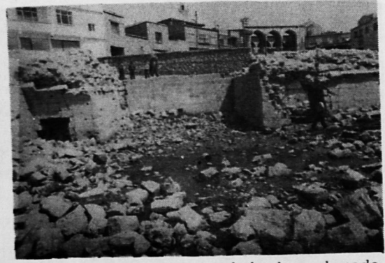
Resim 12 : Hani, Medrese, avludan kuzey kanada bakış
