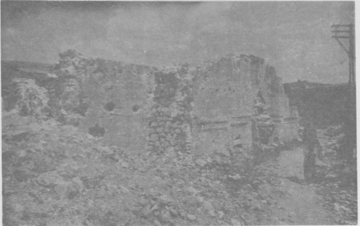
Resim 5 : Hani, Medrese, güney cephe, batıdan görünüş
