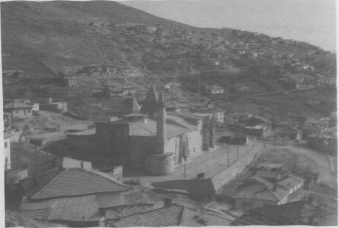
Resim 18 : Divriği Şehrinin Genel Görünüşü ve Ulu Cami
