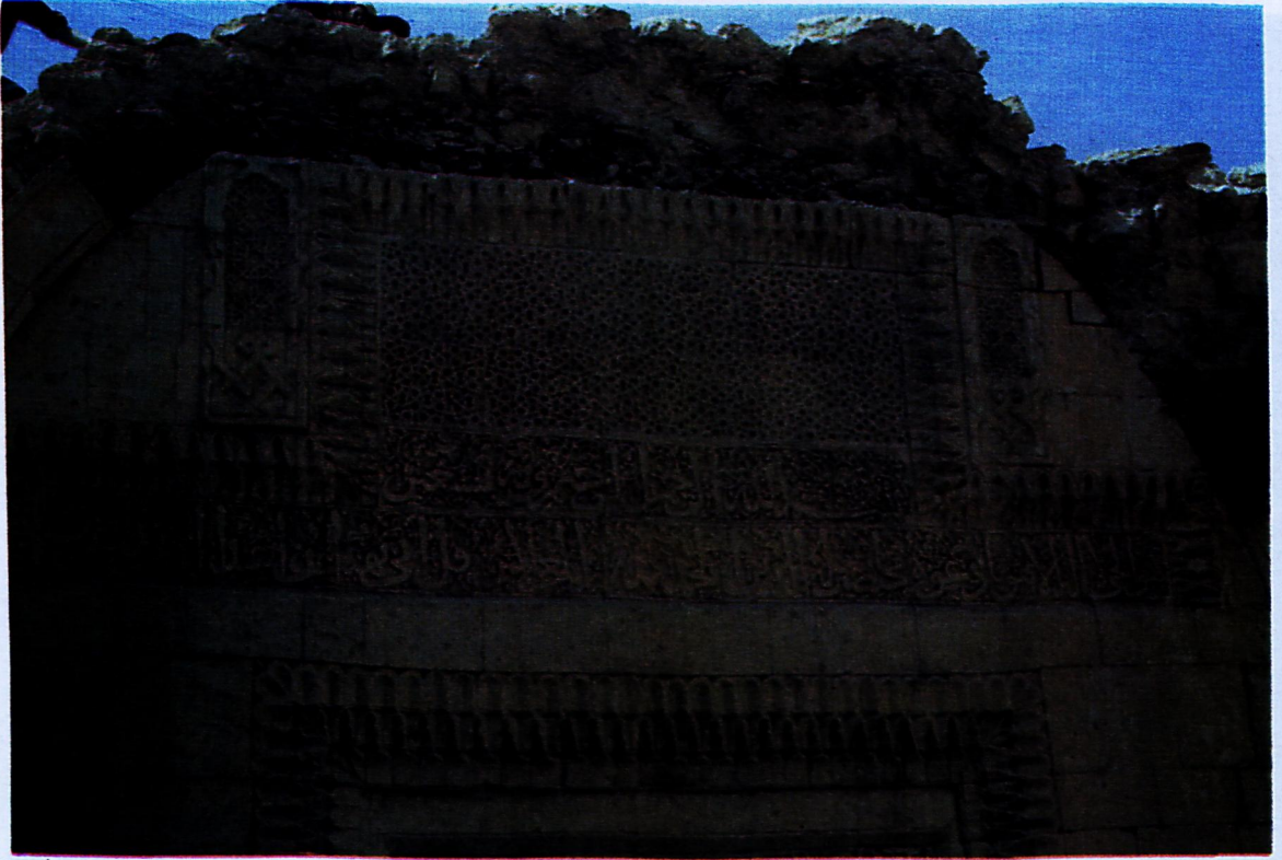
Resim 39 : Hani, Medrese, ana eyvan, güney duvarın üst bölümü
