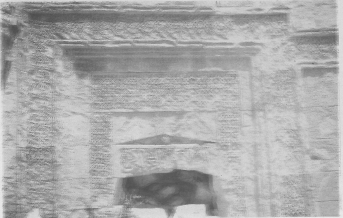
Resim 9 : Hani, Medrese, güney cephe, doğudaki ana eyvan penceresinden ayrıntı.
