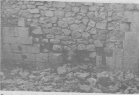
Resim 31 : Hani, Medrese, güneydoğu mekân, güney duvar (Vakıflar Genel Müdürlüğü, Fotoğraf Arşivi'nden)
