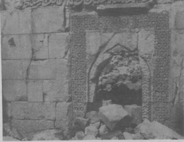
Resim 26 : Hani, Medrese, ana eyvan, batı duvarın orta bölümü
