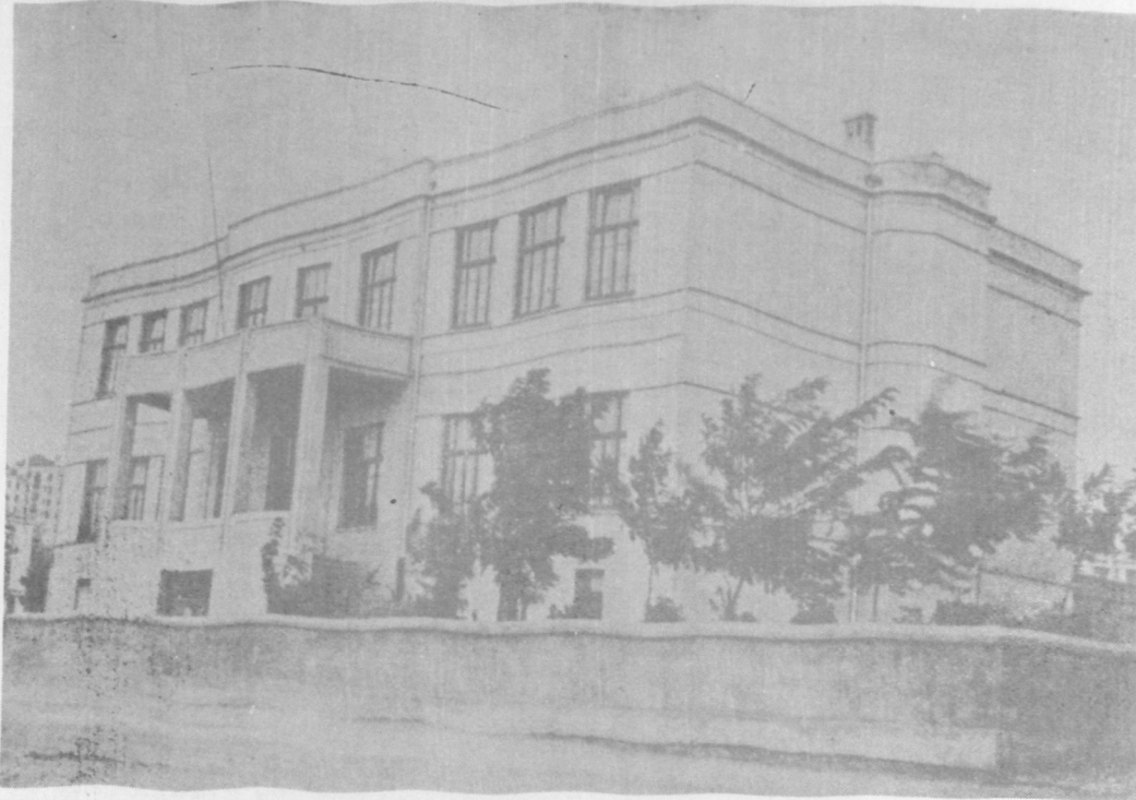
RESİM : 14- Hukuk Fakültesi olarak yapılan ve uzun süre Hukuk Fakültesi olarak hizmet gören bina (Şimdi Ankara Müftülüğü hizmet binası)
