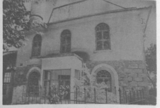
FOTO. 10- Şadırvanlı Camii kuzey cephesi
