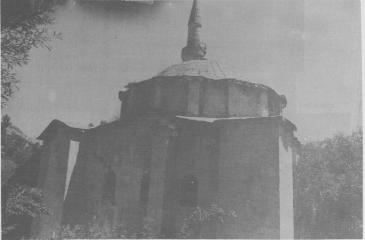
2 - Caminin üst yapısı ve örtü sistemi.
