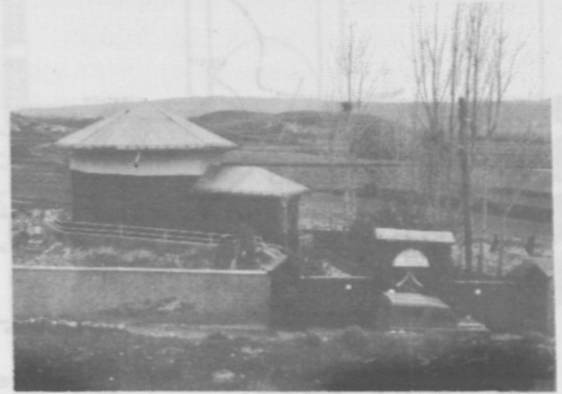
31- Zara-Tekke Köyü Şeyh Merzuban Türbesi
