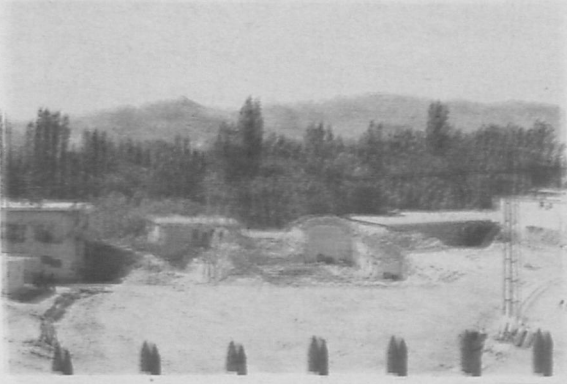
Resim 1 : Hani, Medrese, kuzeyden genel görünüş
