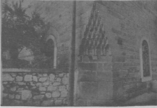
FOTO. 9- Şadırvanlı Camii güneybatı köşesi
