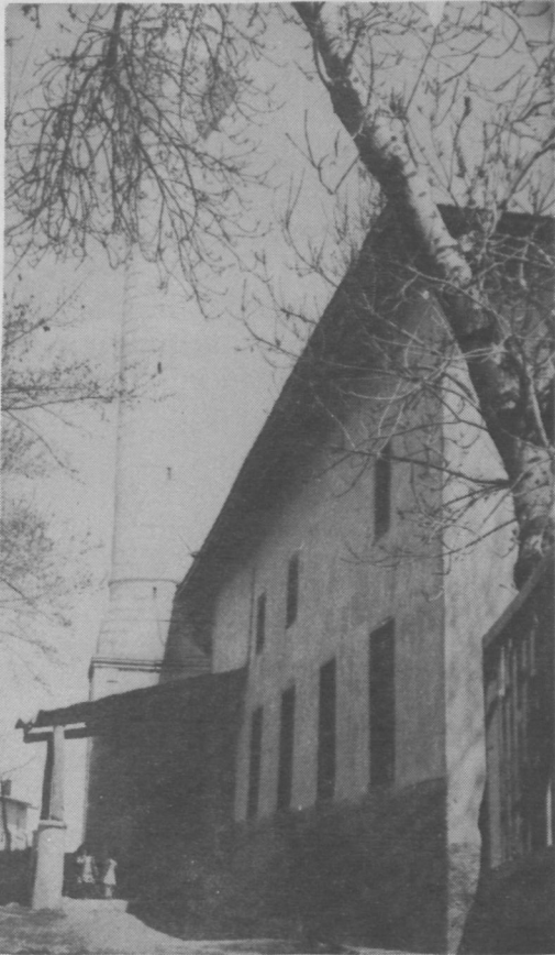
RESİM 2- Pir Hüseyin Bey Cami Batı cephesi
