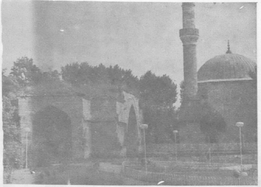
Foto No 18: Havsa Sokollu Külliyesi Dua Kubbesi ve Cami (1988)
