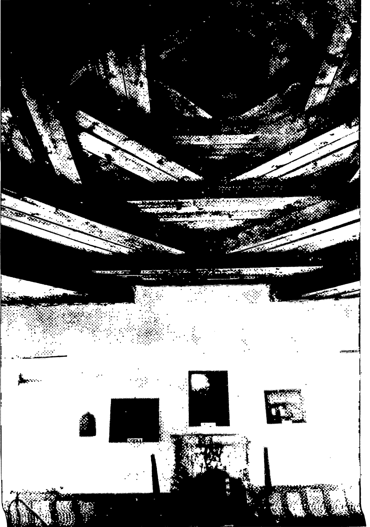
Resim 6: Hacı Bektaş Tekkesi'nde meydanın tüteklilikli örtüsü.
