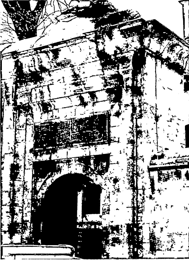
Resim 9: Ayazma Camii, Kuzey Avlu Giriş Portalı Dış Cephesi.
