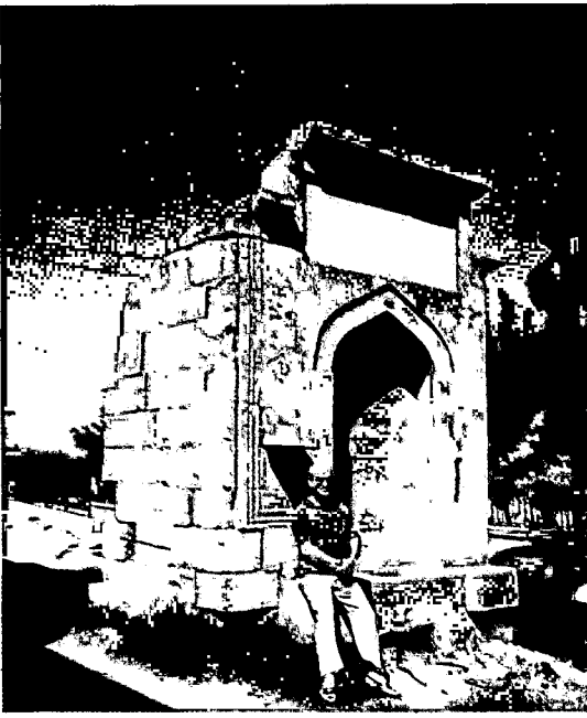
Resim 18: Edirne'de Amcazade Hüseyin Paşa Çeşmesi (Önde Oturan Zat Değerli Tarih Araştırmacılarından Sayın Oral Onur.)
