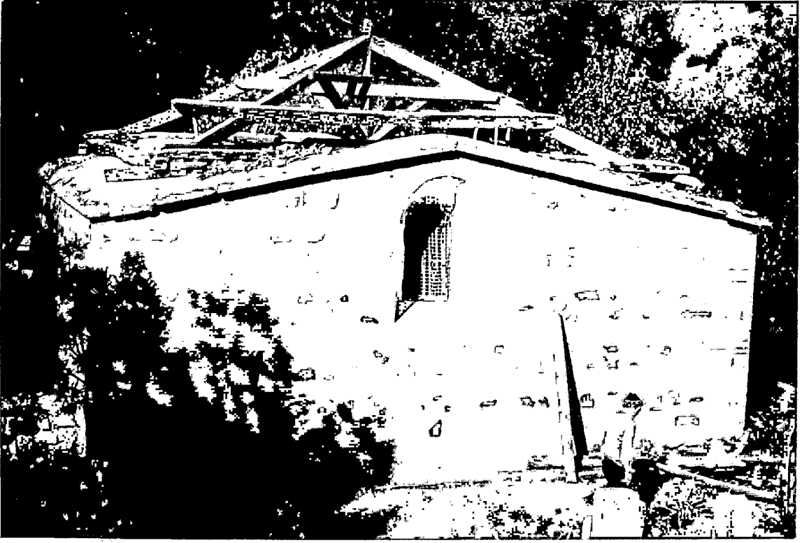
Resim 4: Niksar Melikgazi Türbesi Restorasyon Öncesi 1987 (VGMA)
