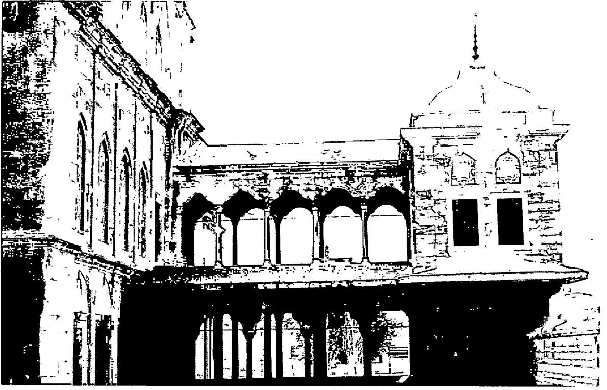
Resim 6: Ayazma Camii, Doğu Cephesi Hünkâr Mahfeli Dış Görünüşü.
