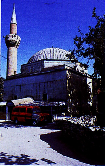
Lev. 58: Gebze, Orhan Gazi Camii, kuzey cephe.
