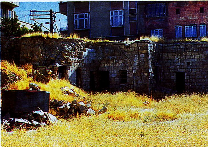
Res. 9: Han, avlunun doğu kenarındaki eyvan.
