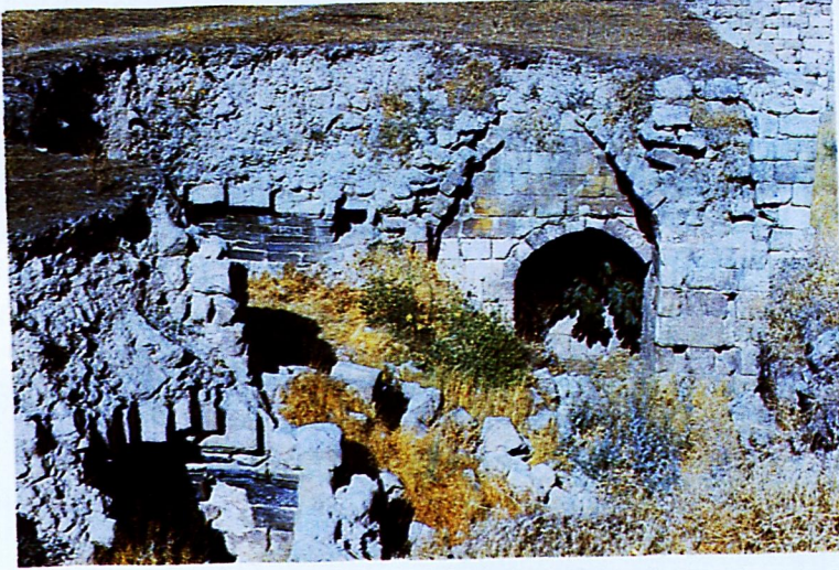
Res. 18: Han, avlunun güney kenarının doğu kısmı.
