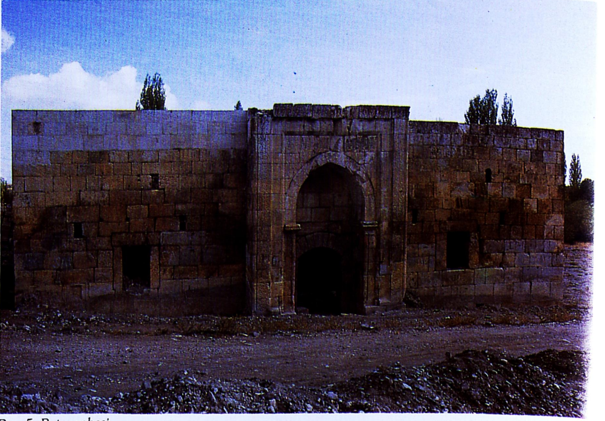
Res. 5: Batı cephesi.
