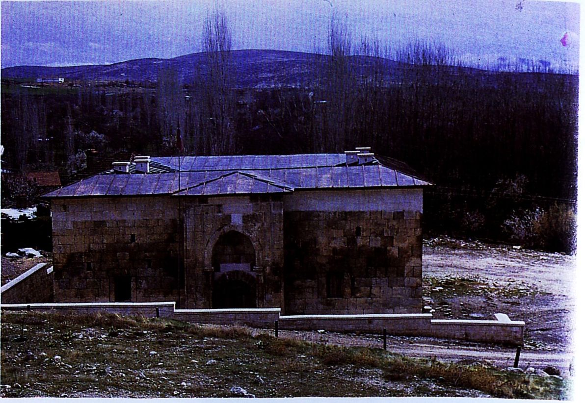
Res. 26: Onarımdan sonra batıdan genel görünüş (1994).
