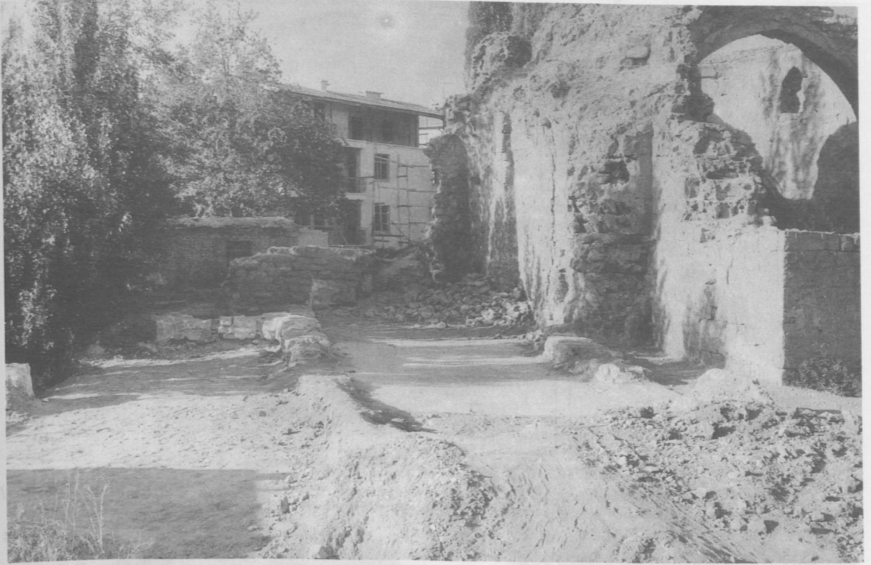
Res.9: Aksaray-Melik Mahmud Gazi Hangâhi, temizlik sonrası görünüşü, Ağustos 1993.
