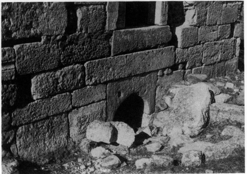
Res. 12: Altınekin İsimless Türbe'nin güney cephesi
