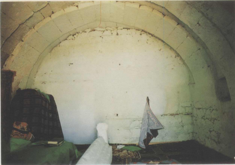
Res. 12: Türbe iç mekan
