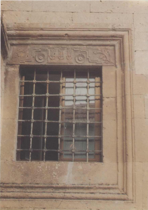
Res. 11: Danış Ali Bey Camii batı cephesindeki minarenin hemen güneyindeki pencere
