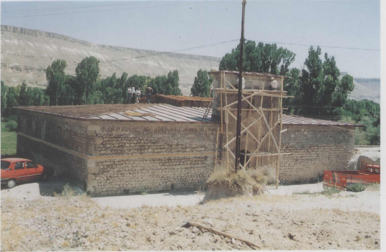
Res. 24: Taşkın Paşa Medresesi, onarımdan sonra
