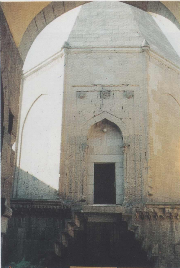
Res. 4: Kayseri Köşk Medrese Türbesi
