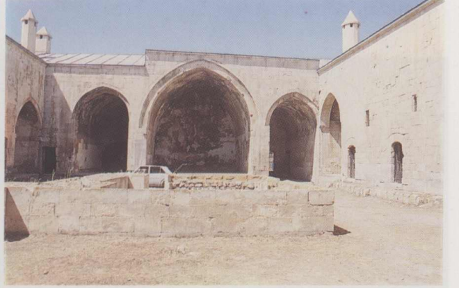
Res. 24: Tercan Mama Hatun Kervansarayı, avlu, kuzeye bakış (1989)
