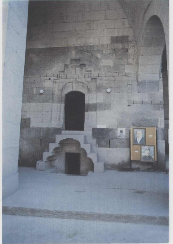
Res. 38: Kayseri Gevher Nesibe Türbesi, batıdan görünüm (1986)
