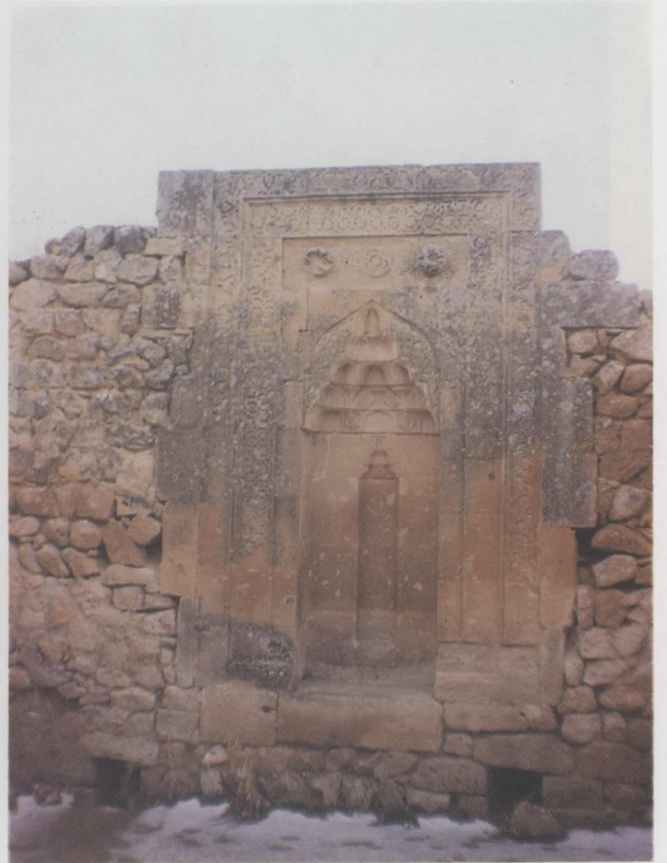
Res. 26: Taşkın Paşa Medresesi mescidi mihrabı onarımdan önce
