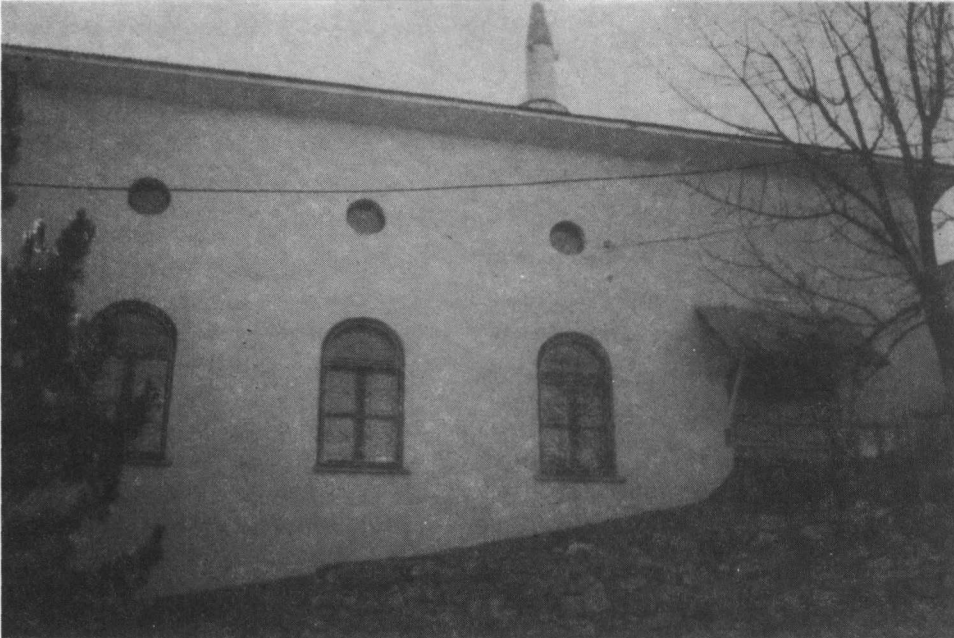
Res. 3: Hadim Taşpınar Mahallesi'nde Hadimî Medresesi'nin ortasında bulunan ve 1960'da yeniden inşa edilen cami
