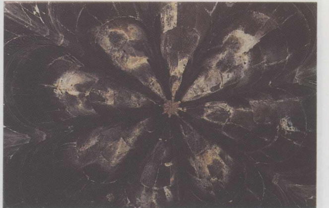
Res. 27: Tercan Mama Hatun Türbesi, içten örtü sistemi (1989)
