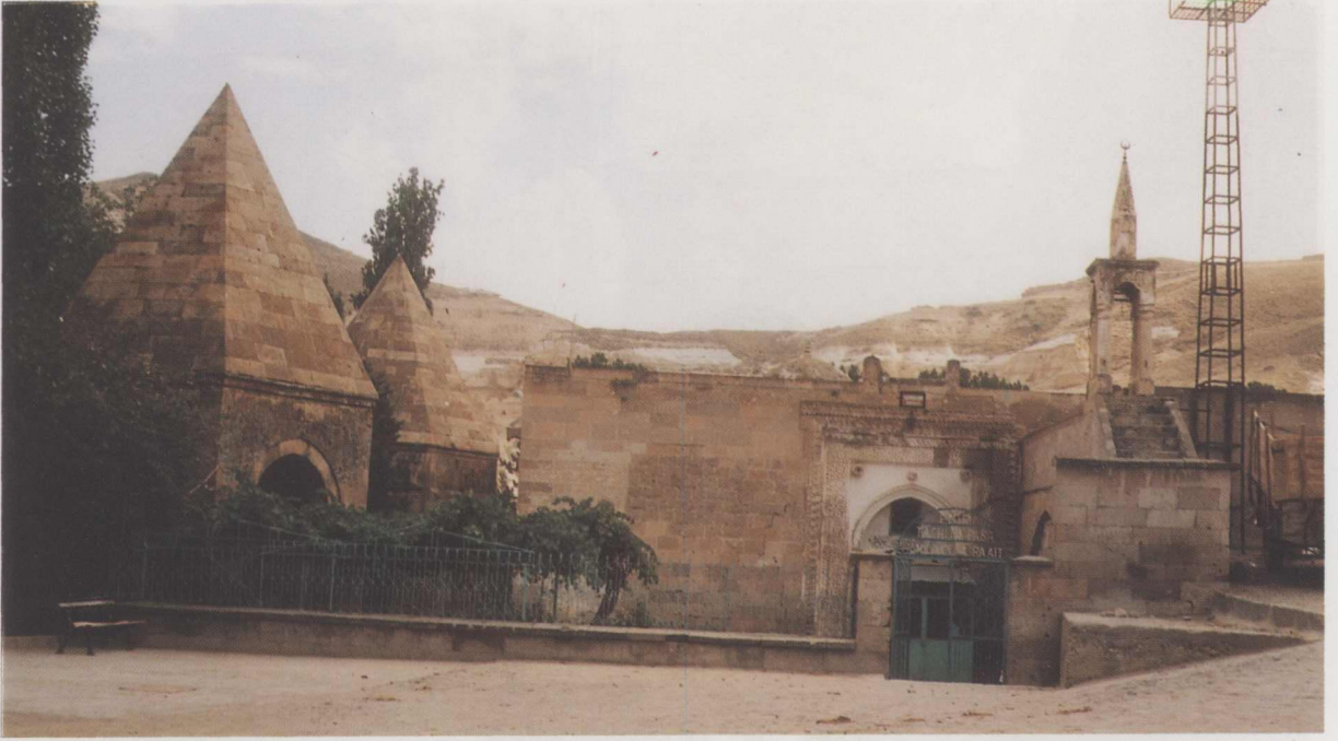
Res. 12: Ürgüp Taşkınpaşa Köyünde Taşkın Paşa yapıları
