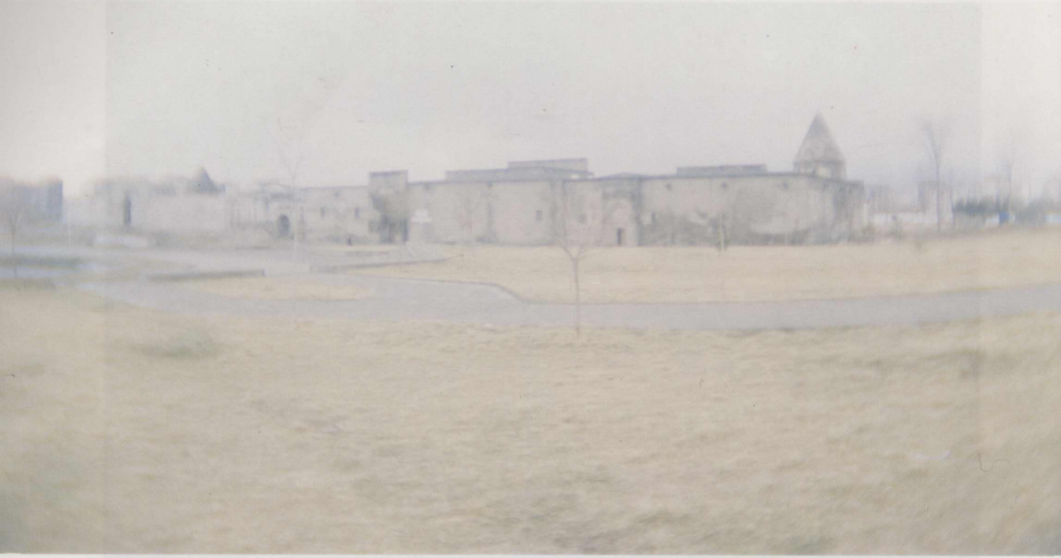
Res. 35: Kayseri Gevher Nesibe Darüşşifası ve Medresesi, güneyden görünüm (1993)
