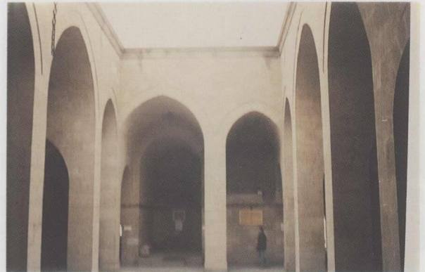
Res. 36: Kayseri Gevher Nesibe Darüşşifası, avlu, güneye bakış (1993)
