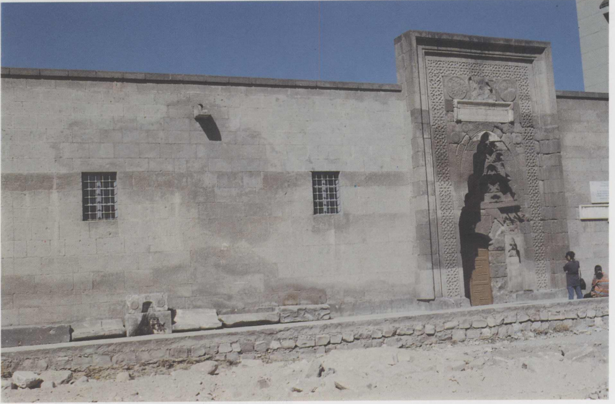
Res. 39: Kayseri Gevher Nesibe Darüşşifası, güney cephe ve portal (1986)
