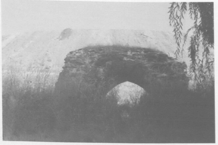
Res.8: Dört ayaklı yapının yakından görünüşü.
