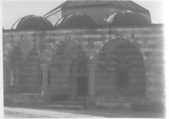
Res.16: Pertek, Çelebi Ali Camii, kuzey cephe.
