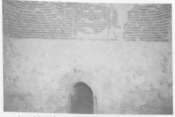
Lev. 13: Balta Bey Hamamı, ılıklik, batı duvar.
