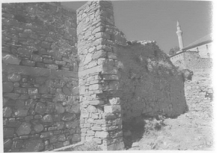
Lev. 6: Balta Bey Hamamı, güney cephe ayrıntı.
