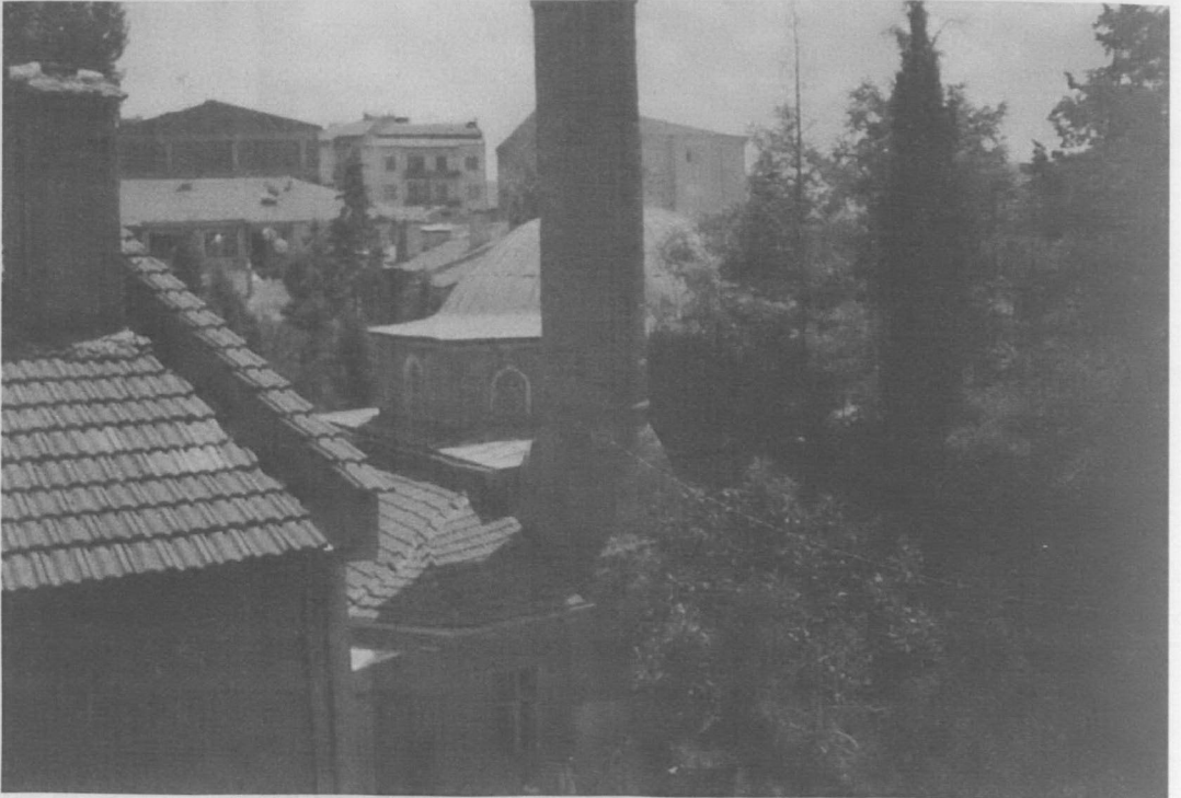
Res. 4: Bodurođlu Camii'nin çatısı.
