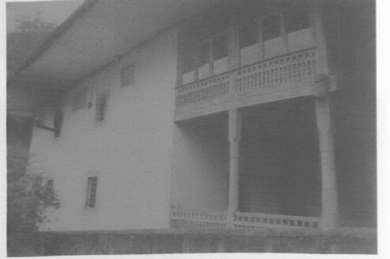
Res.5: Caminin doğu cephesi ve camekanlı dış mahfil.
