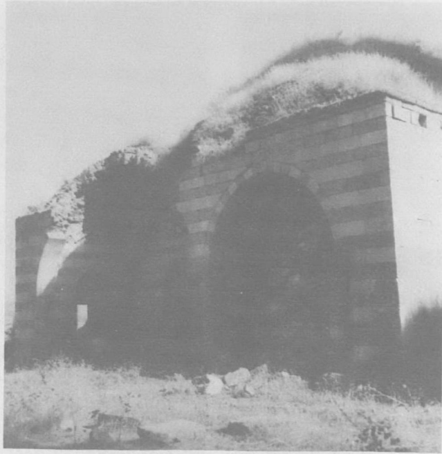
Res.15: Pertek, Çelebi Ali Camii, kuzey cephe, taşınmadan önceki durumu (VGM Arşivi).
